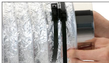
5. Kabelbinder auf der noch freien Seite des HVAC Clips einfädeln und anziehen bis der Spiralschlauch fixiert ist.
